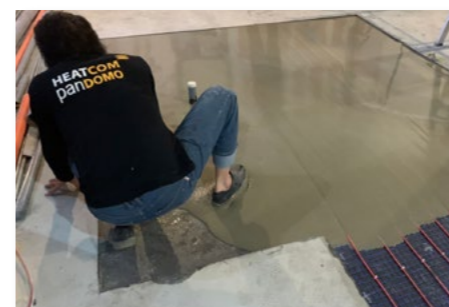
■ 自平砂漿保護層鋪設
